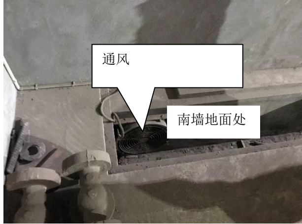
图 12 探伤房通风装置
