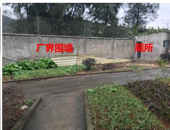
图 4 探伤房北侧厂界围墙及厕所
